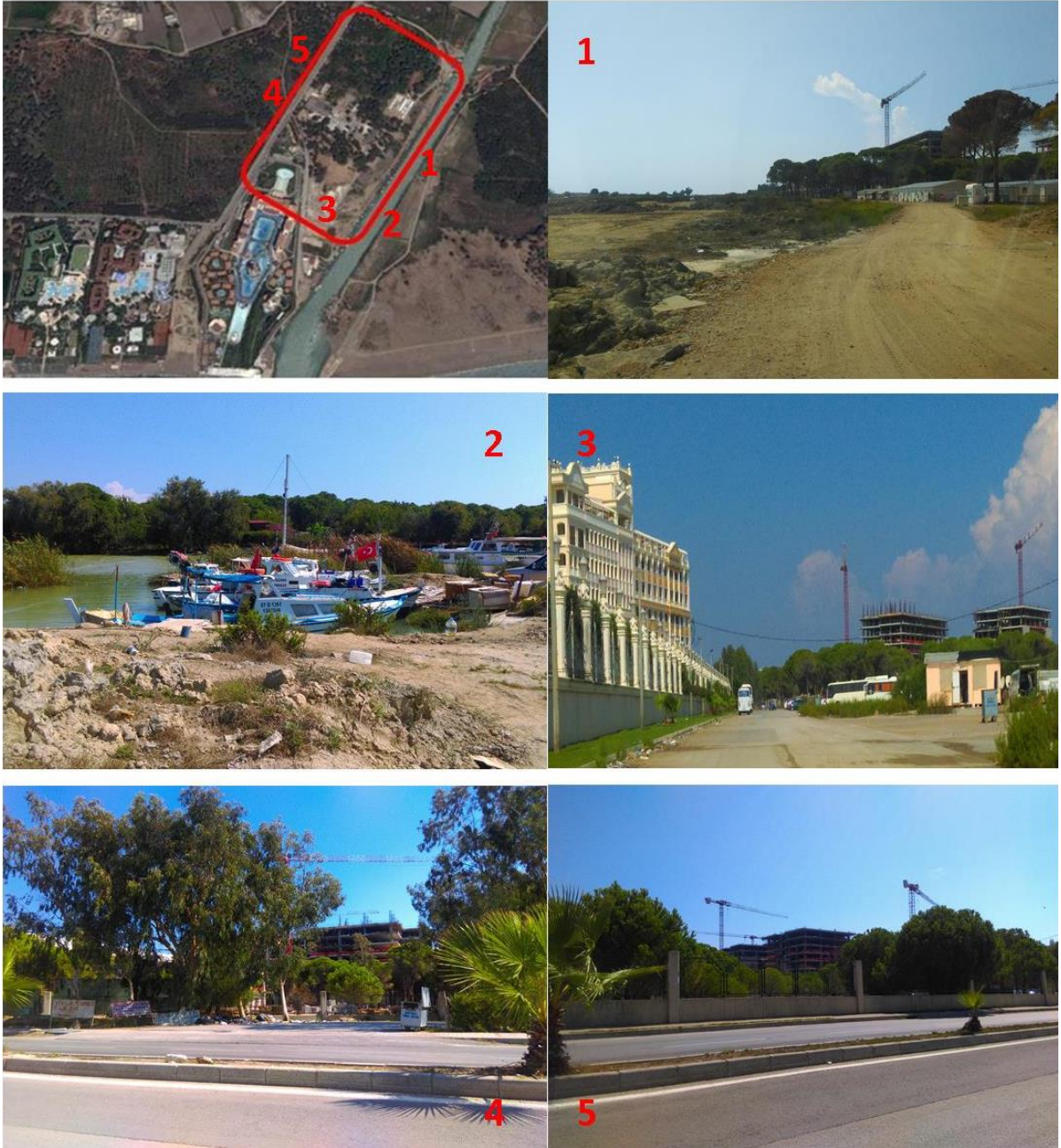
Fotoğraf 2.20. Aksu Çayı Kıyı Şeridi Yeni Otel İnşaatları
