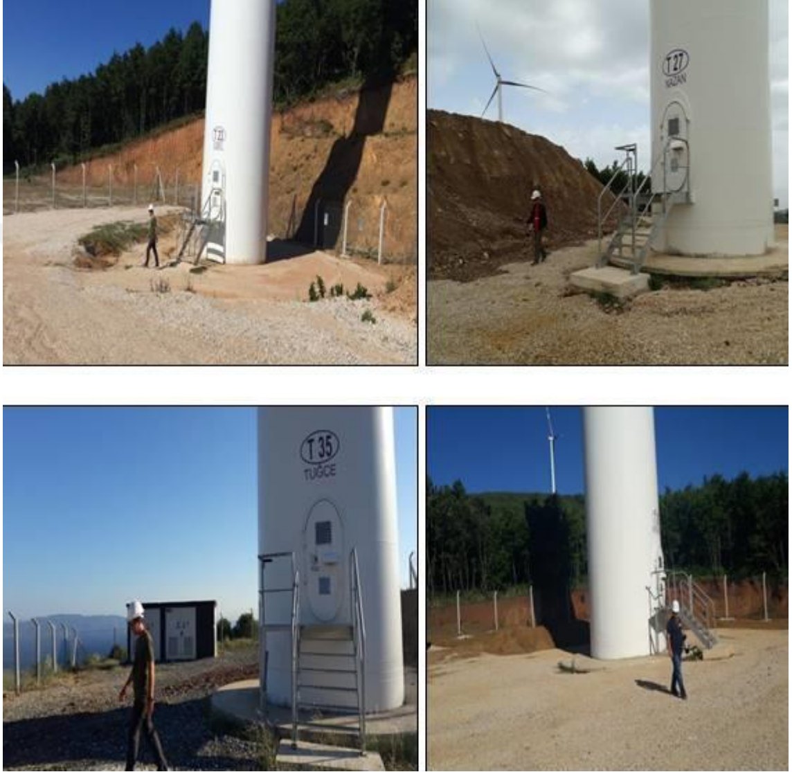
Şekil 3.15. Yalova RES sahasında yürütülen karkas tarama çalışmaları
