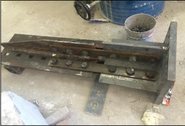
Şekil 3.23. Sabit plakaların birleşimi (bağlantı elemanlarının montajından sonra)
