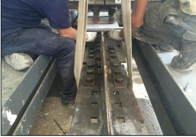
Şekil 3.24. Sabit plakaların montajı
