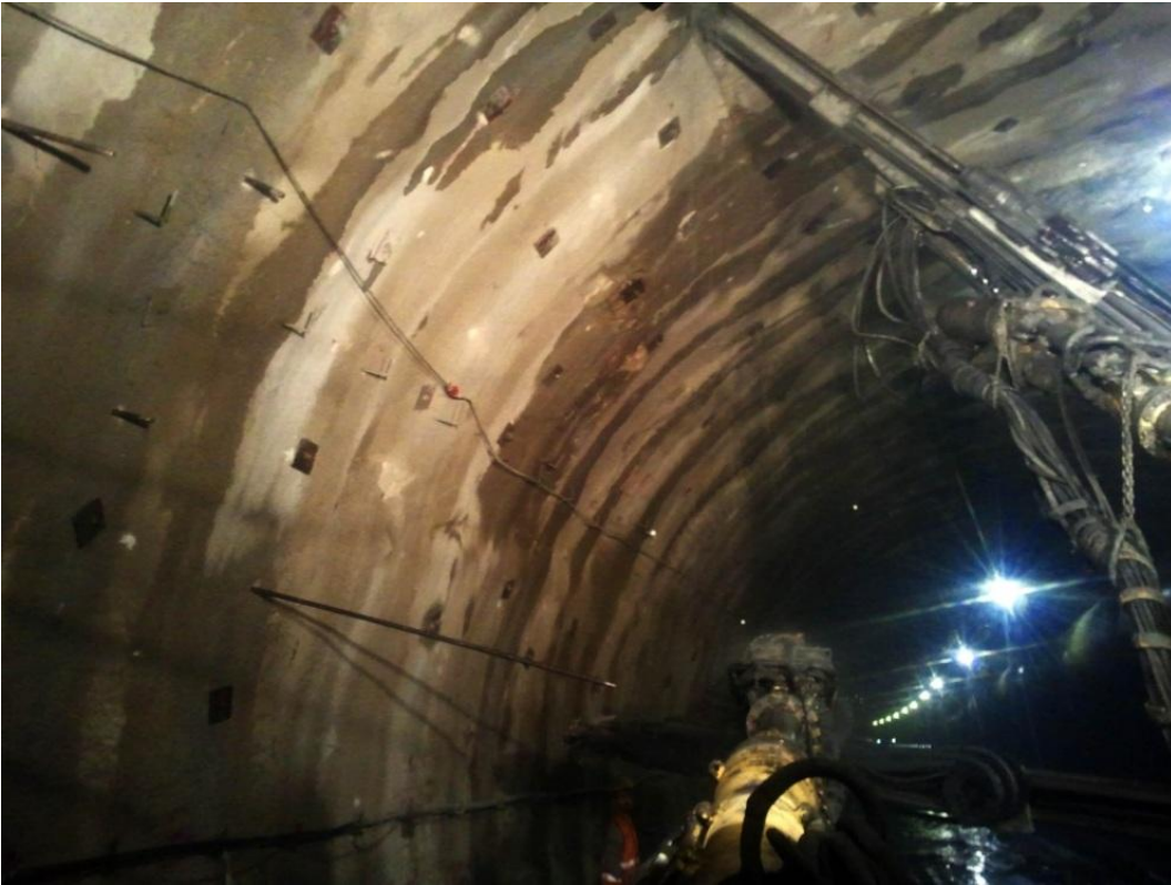
Şekil 3.7. Kaya bulonu imalat aşaması (Samanlı Tüneli sağ tüp)
