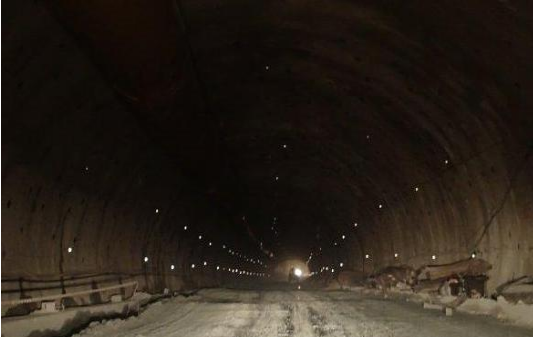
Şekil 3.15. Tünel içerisindeki deformasyon istasyonları ve ölçüm noktaları
