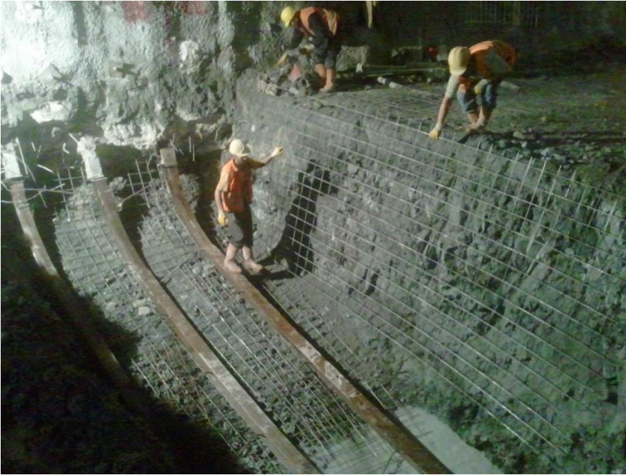
Şekil 3.5. Taban (invert) kazı ve destekleme aşaması (Samanlı Tüneli sol tüp)
