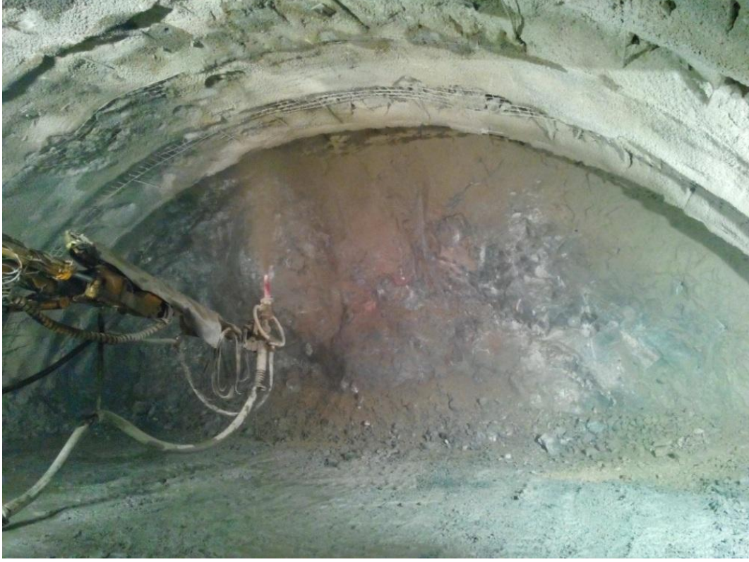
Şekil 3.8. Püskürtme betonu uygulama aşaması (Samanlı Tüneli sol tüp)
