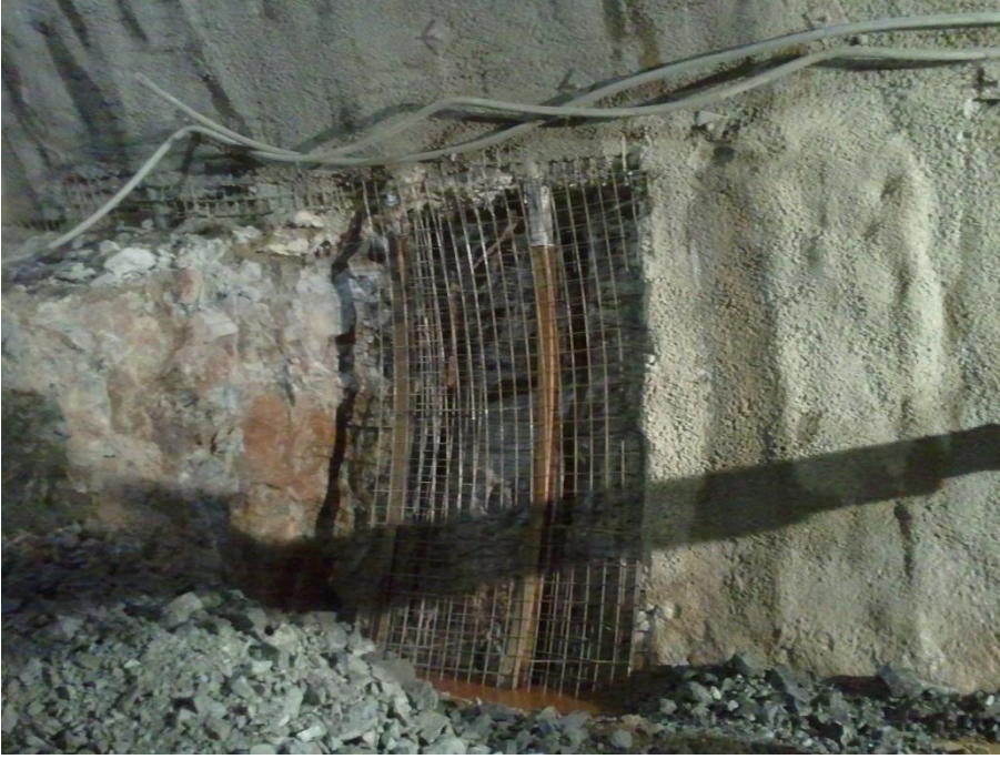
Şekil 3.4. Altyarı kazı ve destekleme aşaması (Samanlı Tüneli sol tüp)
