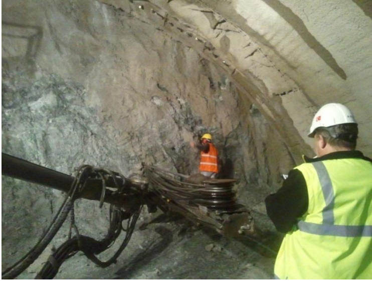
Şekil 3.13. Araştırma delgisi ve değerlendirme aşaması (Samanlı Tüneli sağ tüp)
