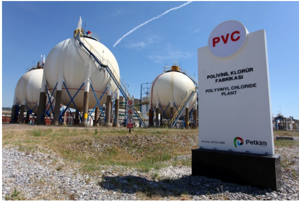
Resim 2.5 Polivinil Klorür Fabrikası Levhası
