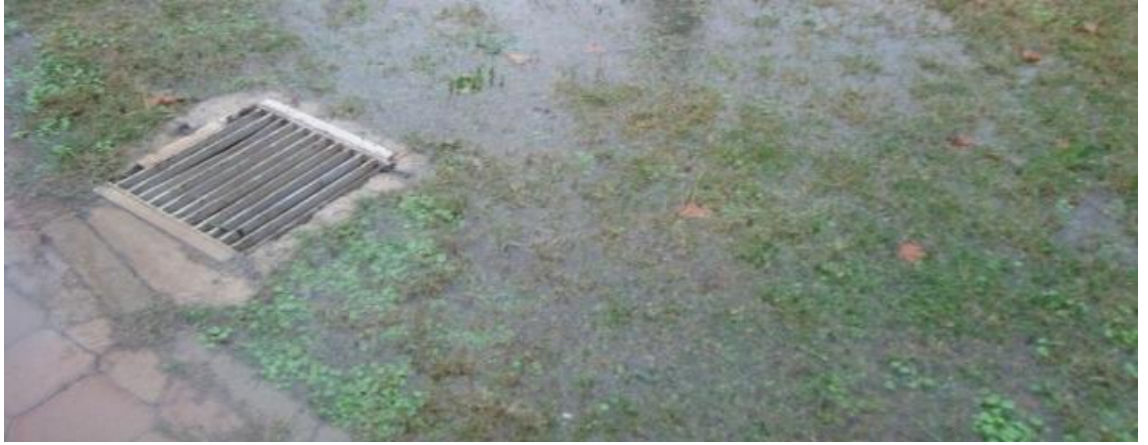
Şekil 4.10. 23 Nisan Parkı mevcut drenaj yapıları-5
