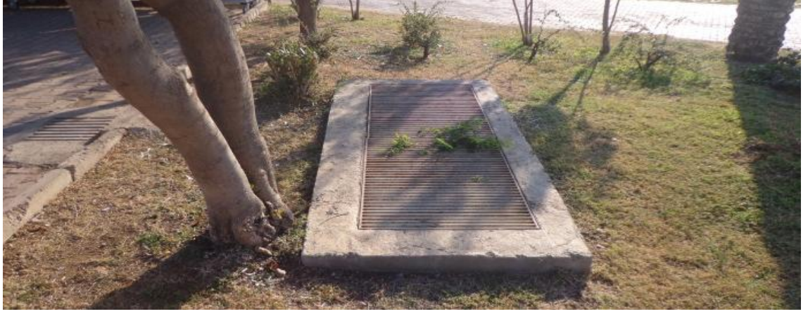
Şekil 4.9. 23 Nisan Parkı mevcut drenaj yapıları-4
