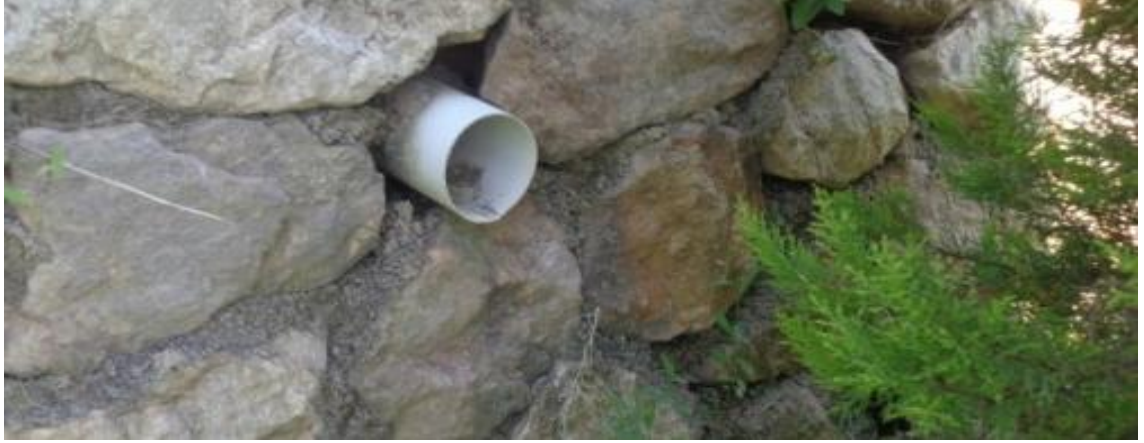
Şekil 4.11. 23 Nisan Parkı mevcut drenaj yapıları-6
