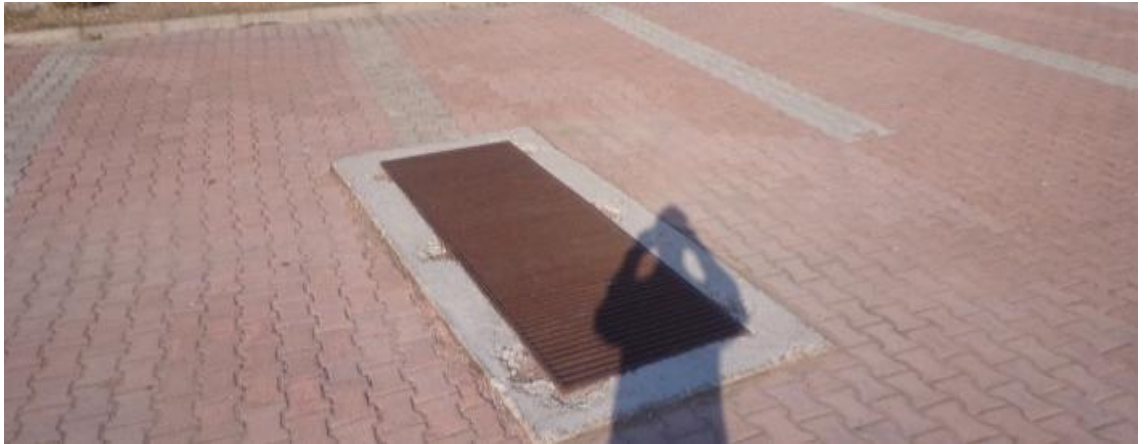
Şekil 4.8. 23 Nisan Parkı mevcut drenaj yapıları-3
