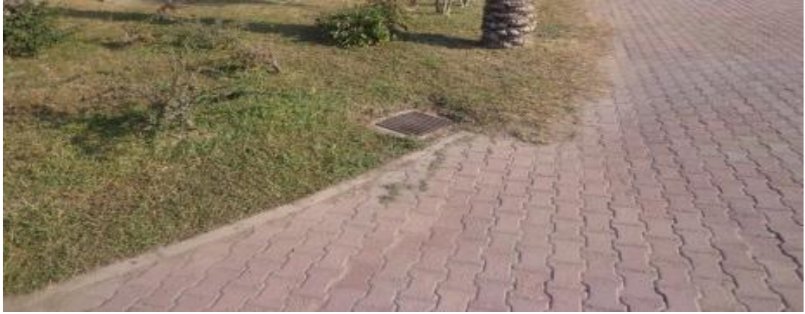
Şekil 4.5. 23 Nisan Parkı mevcut drenaj yapıları-1
