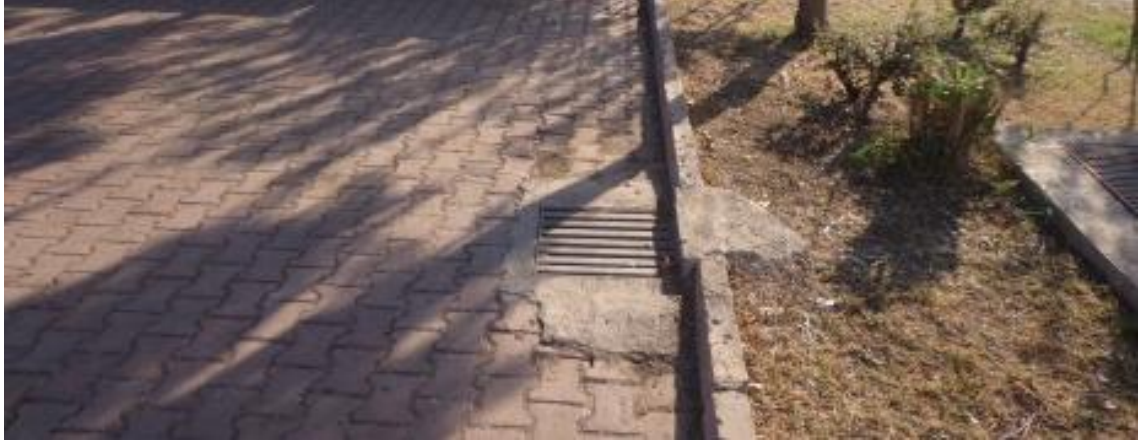
Şekil 4.7. 23 Nisan Parkı mevcut drenaj yapıları-2
