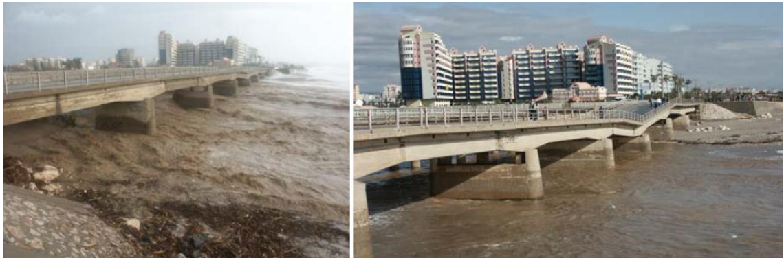
Şekil 4. 5. 2003 yılında yaşanan taşkın sonrası yıkılan Boğaçay köprüsü (Çoşar 2011)
