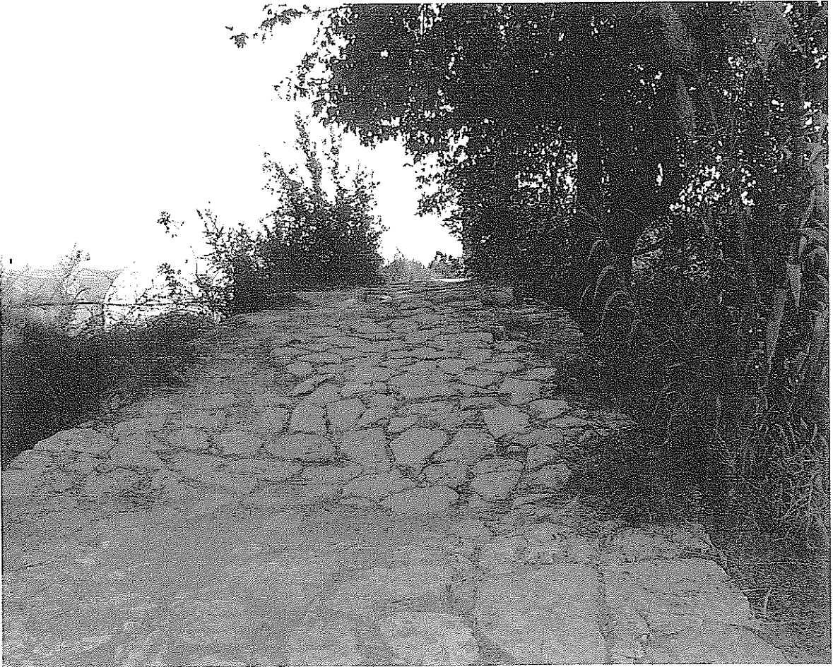
Foto. 2: Kırkgöz Köprüsü'nün batı başlangıcı.
