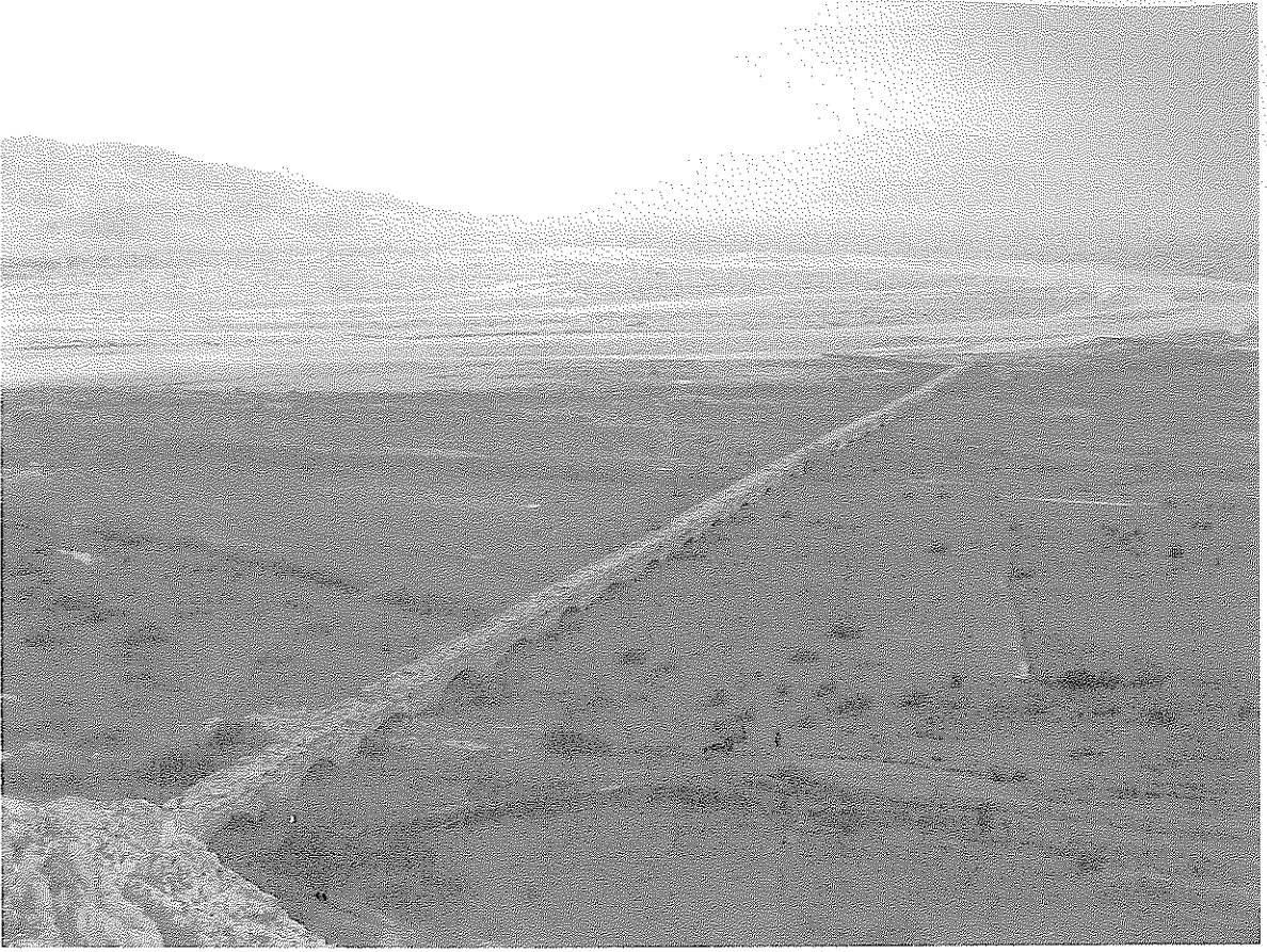
Foto. 1: Kırkgöz Köprüsü ve Alakır Çayı.
